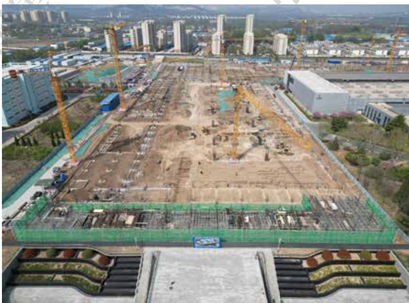
图 1 山东中烟公司青州卷烟厂就地技术改造工程总承包项目施工现场
